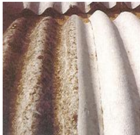
Particolare di una lastra in AC prima (SIN) e dopo l'intervento di pulizia con idropulitrice
